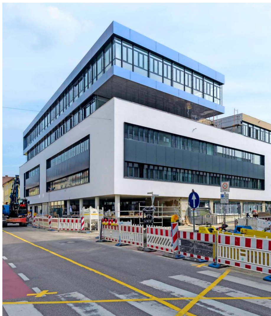
Eines der jüngsten Projekte der Öhringer Bauunternehmung Gauer war der Neubau eines Bürogebäudes an der Ecke Uhlandstraße/Wollhausstraße in Heilbronn.
