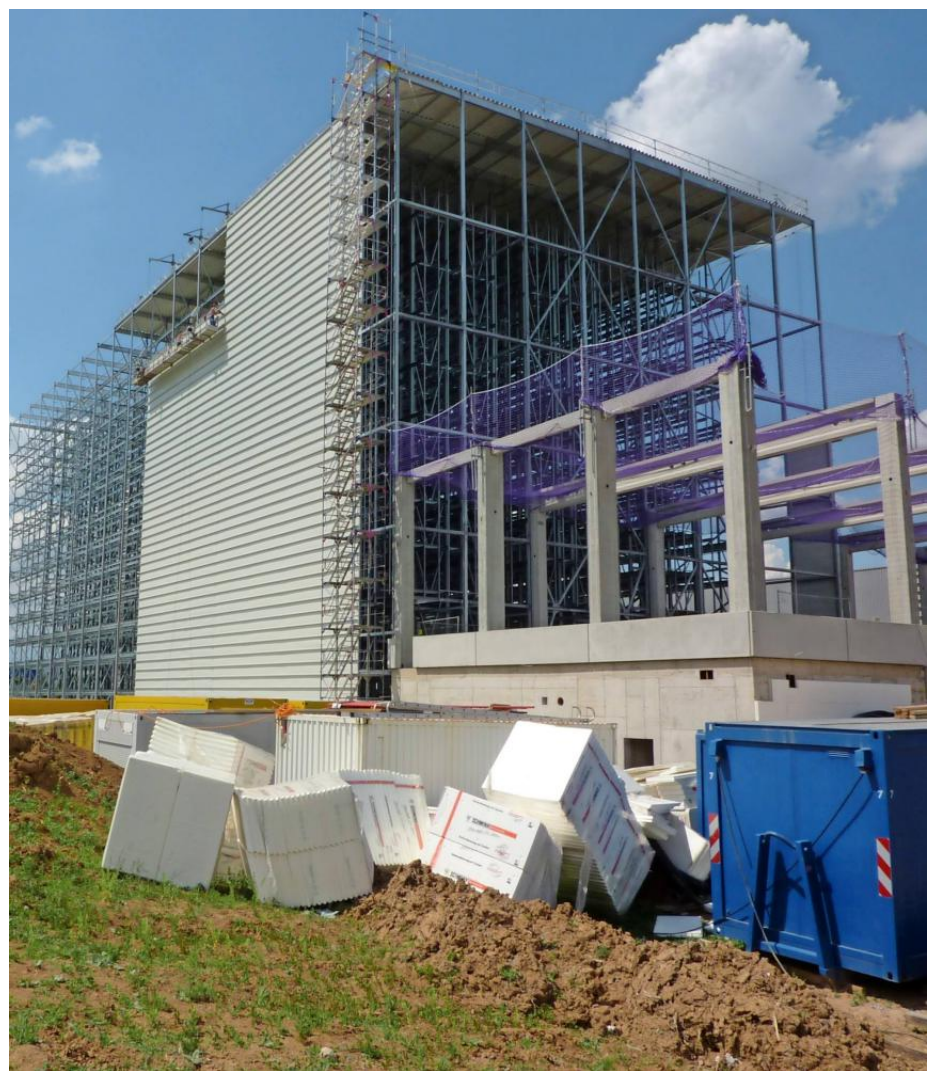
Die Heilbronner Bauunternehmung Böpple errichtete in den vergangenen Jahren unter anderem das neue Hochregallager von Ideal Pack auf den Böllinger Höfen.
